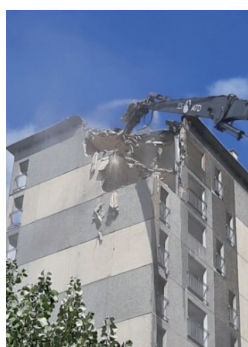
ALLONNES - Immeuble Chabrier en démolition
